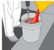
Coloca agua en un recipiente (máximo 5.5 litros) y vacía gradualmente **Sikafloor® Level Industrial**. Mezcla 3 minutos con taladro de bajas revoluciones\*\*.
