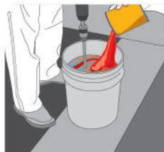
Mezcla los componente A y B con taladro de bajas revoluciones por 3 a 5 minutos, sin agregar burbujas a la mezcla.
